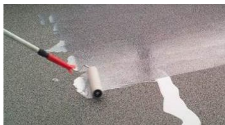
Abb. 3 und 4: Auftragen der Versiegelung
